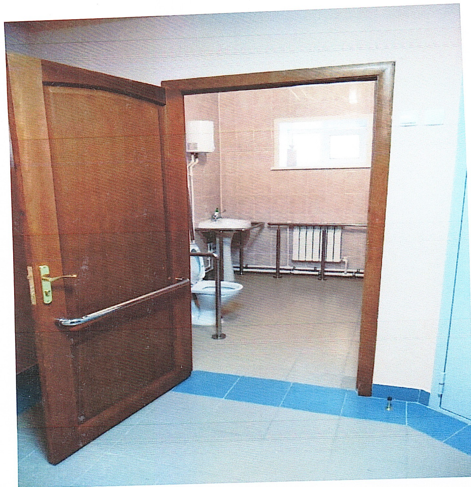
Санитарно-гигиеническое помещение на первом этаже
